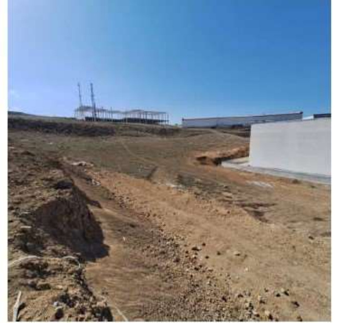
ANKARA İLİ, KAHRAMANKAZAN İLÇESİ, SARAY (İ) MAHALLESİ, 3642 ADA 4 PARSEL
