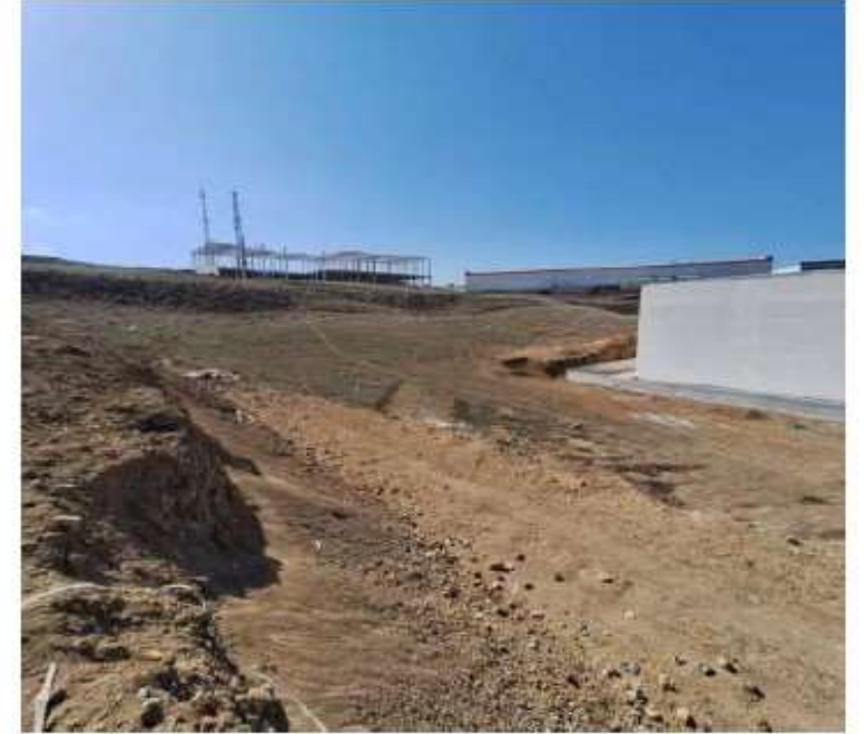
ANKARA İLİ, KAHRAMANKAZAN İLÇESİ, SARAY (İ) MAHALLESİ, 3380 ADA 4 PARSEL
