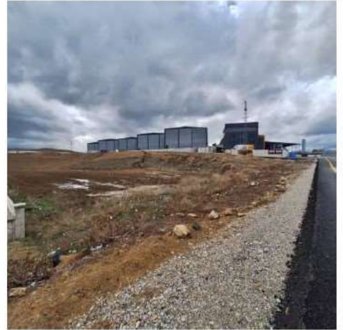
ANKARA İLİ, KAHRAMANKAZAN İLÇESİ, SARAY (İ) MAHALLESİ, 3328 ADA 3 PARSEL
